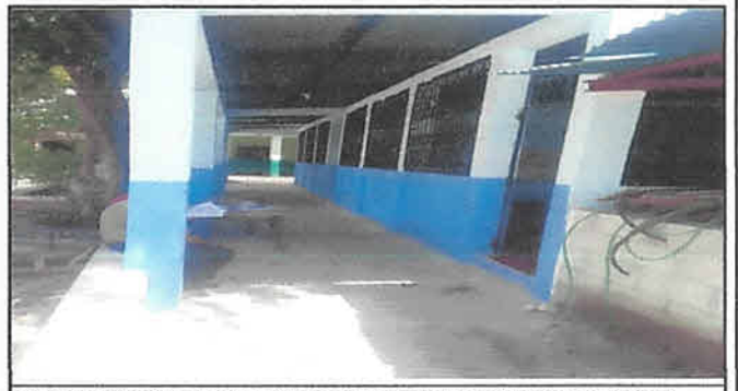
Foto 6: Pastedo y alizado a vigas y columnas a los salones I y II, de igual manera se encuentra en la realización de pintar los dos salones lado afuera.
