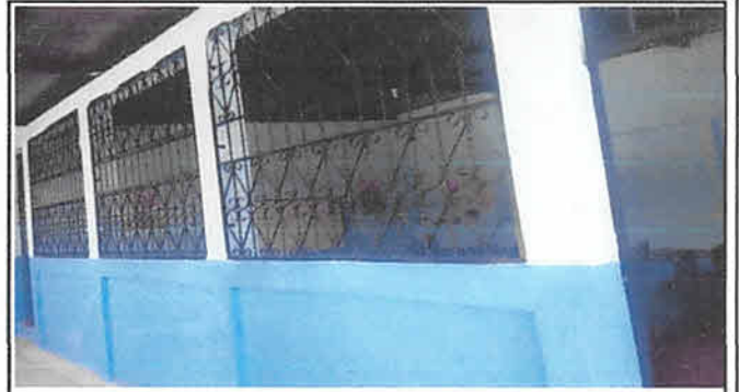
Foto 2: Colocación de Puerta y ventanas al salón II, ya se encuentra en su fase final del pintado del salón II y fuera de ella.
