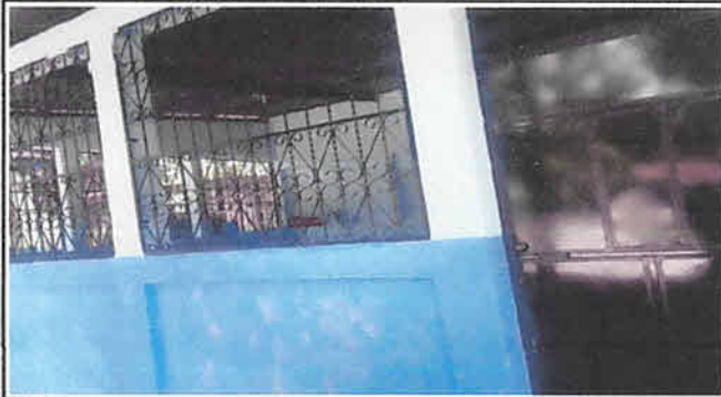
Foto 1: Colocación de ventanas y puerta al salón I, ya se encuentra en su fase final del pintado de salón I dentro y fuera de ella.
