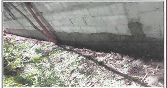
Foto 4: Repello y Alizado atrás del salón II.
