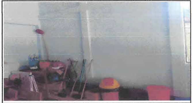
Foto 10: Sellado de las dos ventanas del salón II
