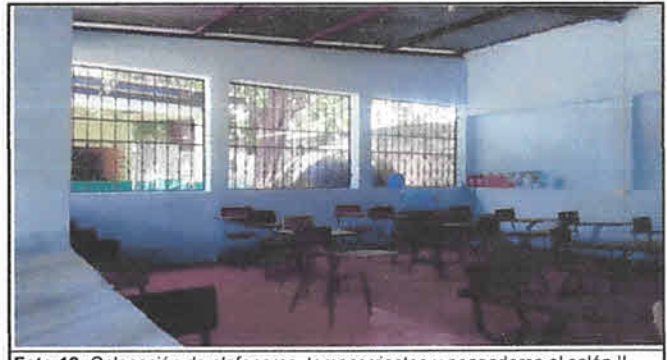
Foto 12: Colocación de plafoneras, tomacorrientes y apagadores al salón II.
