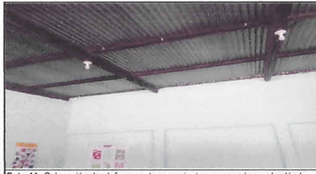
Foto 11: Colocación de plafoneras, tomacorrientes y apagadores al salón I.
