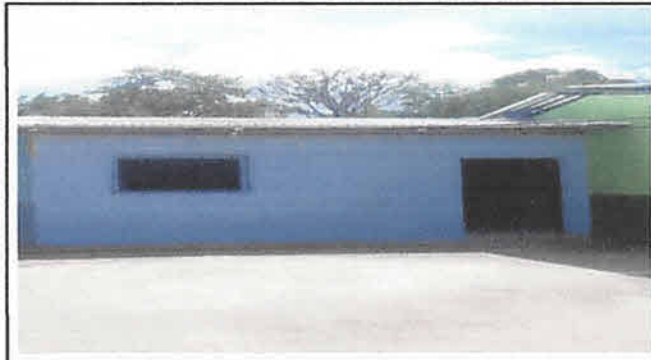
Foto 7: Cambio de techado con estructura de metal y lamina acanalada nueva para la Dirección del centro educativo.
